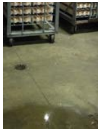
Mantenha todas as áreas as mais secas possíveis, evitando água parada no chão
